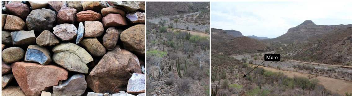
Muro de piedra para no permitir el acceso del ganado a las huertas del rancho Primer Agua
